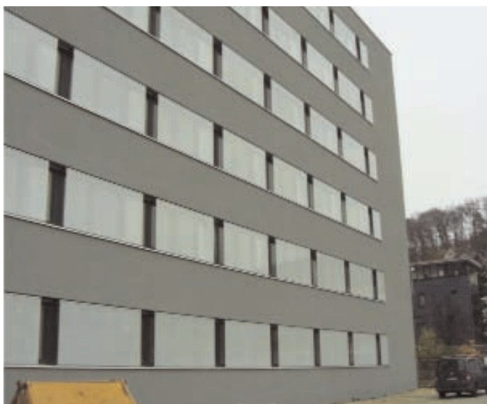
Sehr schlichte Fassadengestaltung – nur die hellen Prallscheiben, als Lichtschutz fast auf die gesamte Laibungsbreite vor die Kunststofffenster gesetzt, sorgen für Pfiff.
