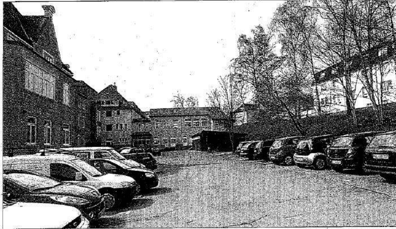
Auf den Parkplätzen zwischen Haus A (Foto links) und B (rechts) der Landkreisverwaltung wird der Erweiterungsbau errichtet. Dazu muss der Seitenflügel mit dem Sitzungssaal (Bildmitte) abgerissen werden. Getagt wird dann in anderen kreiseigenen Gebäuden wie etwa den beruflichen Schulen. Foto: rfp
